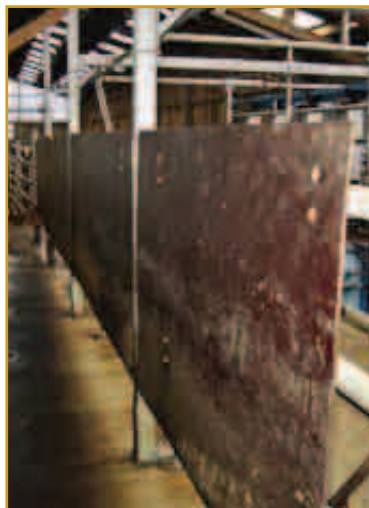
Parois pleines installées sur couloir de retour.
