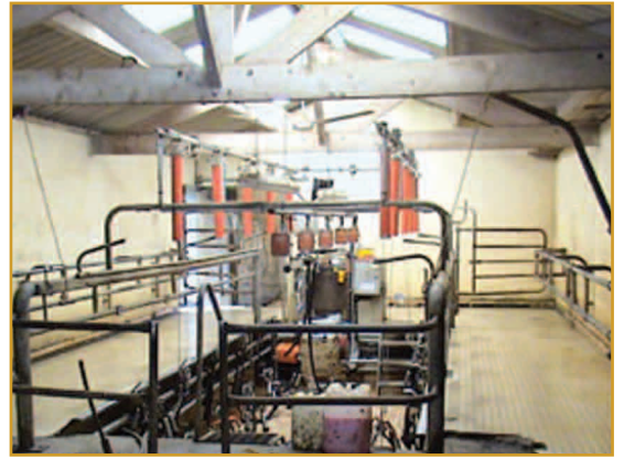
Salle de traite lumineuse avec translucides
