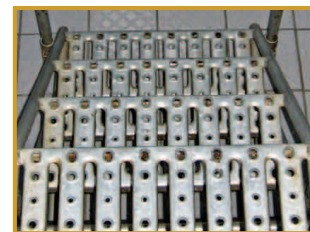
Revêtement antidérapant à grille
