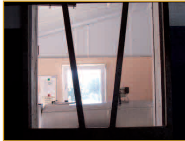
Pont-levis avec éblouissement
