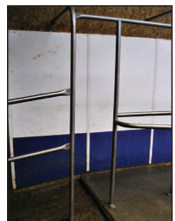
Dimension : 35 cm utiles entre les poteaux (3)
